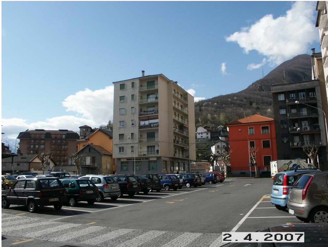
Foto: VILLADOSSOLA - Corso Italia, 10 – piano: 6°
